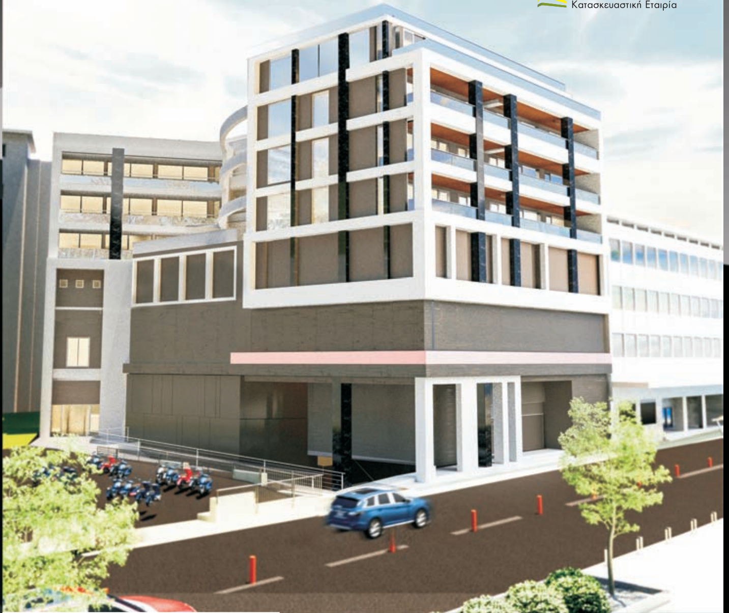
Όψη κτιρίου από την οδό Παπαναστασίου
